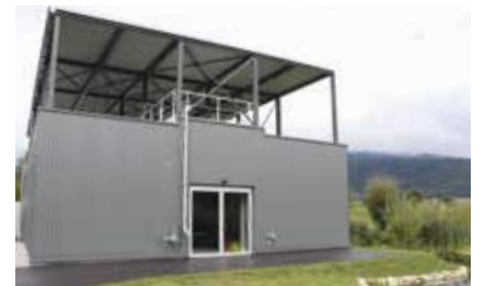
Le nouveau bâtiment des Quarres destiné à la filtration des micropolluants (photo pif).
